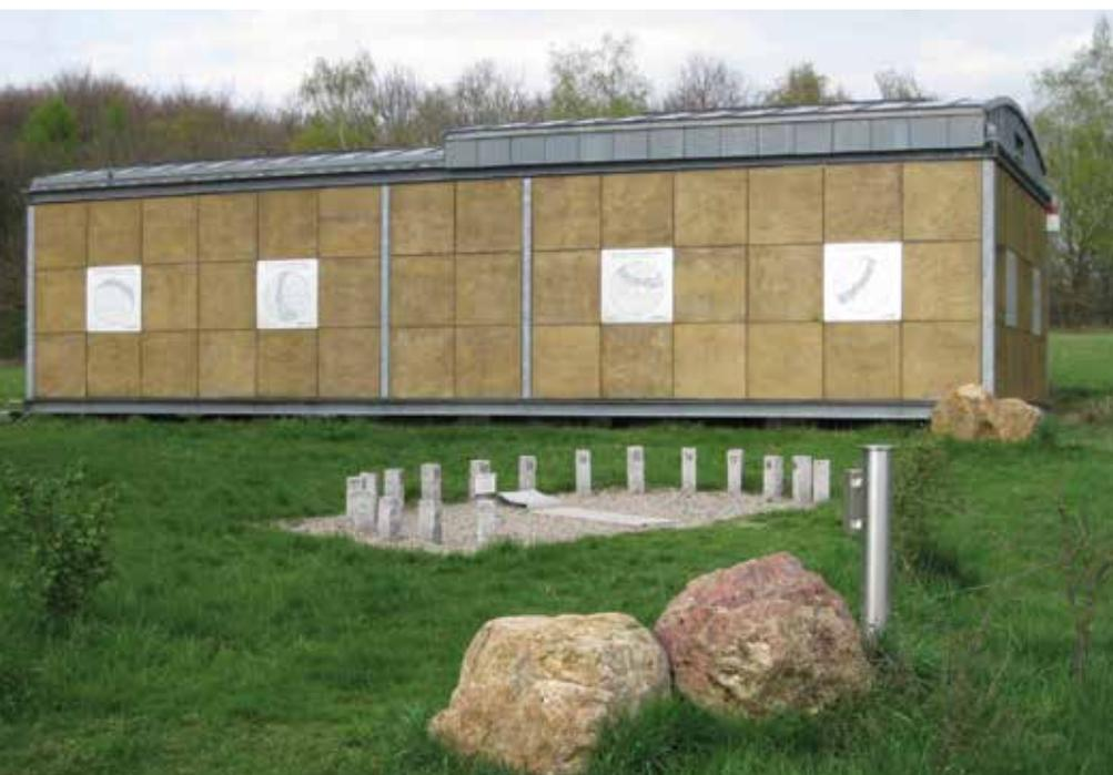
1 Die südliche Dachhälfte des Sternwartengebäudes kann mit einer Handkurbel über die nördliche Hälfte gefahren werden.
